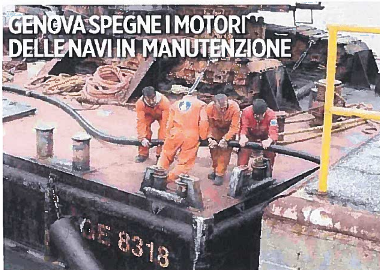
I lavori per la posa del cavo per la connessione elettrica nell'area dell'Ente bacini a Genova
